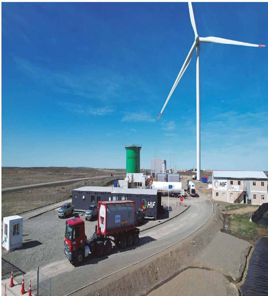
La planta demostrativa Haru Oni de la empresa HIF Global es la primera instalación de eCombustible en funcionamiento del mundo.
