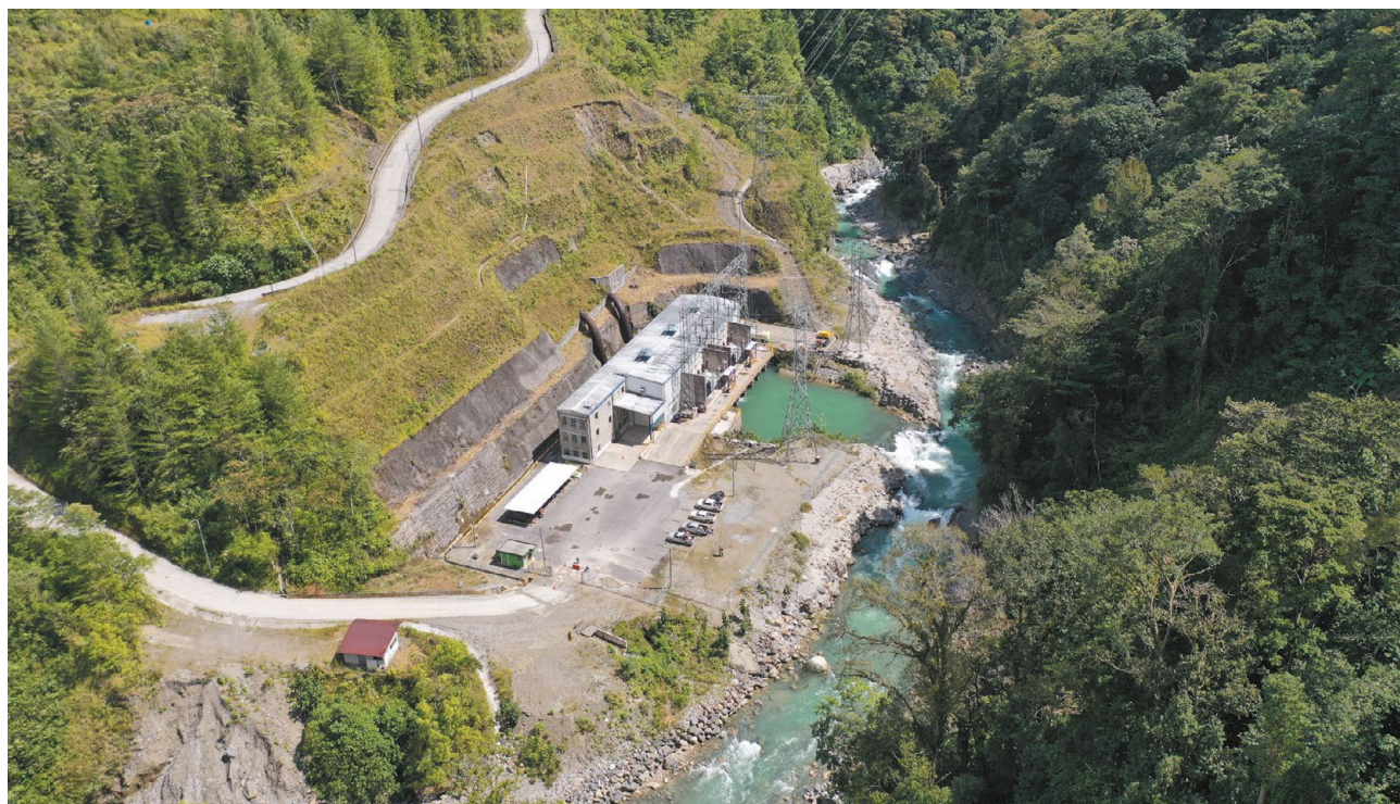
Foto: Enel Central hidroeléctrica Palo Viejo Guatemala.
