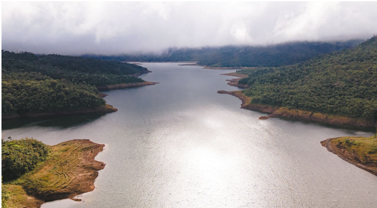
Foto: Enel Central hidroeléctrica Fortuna en Panamá.
